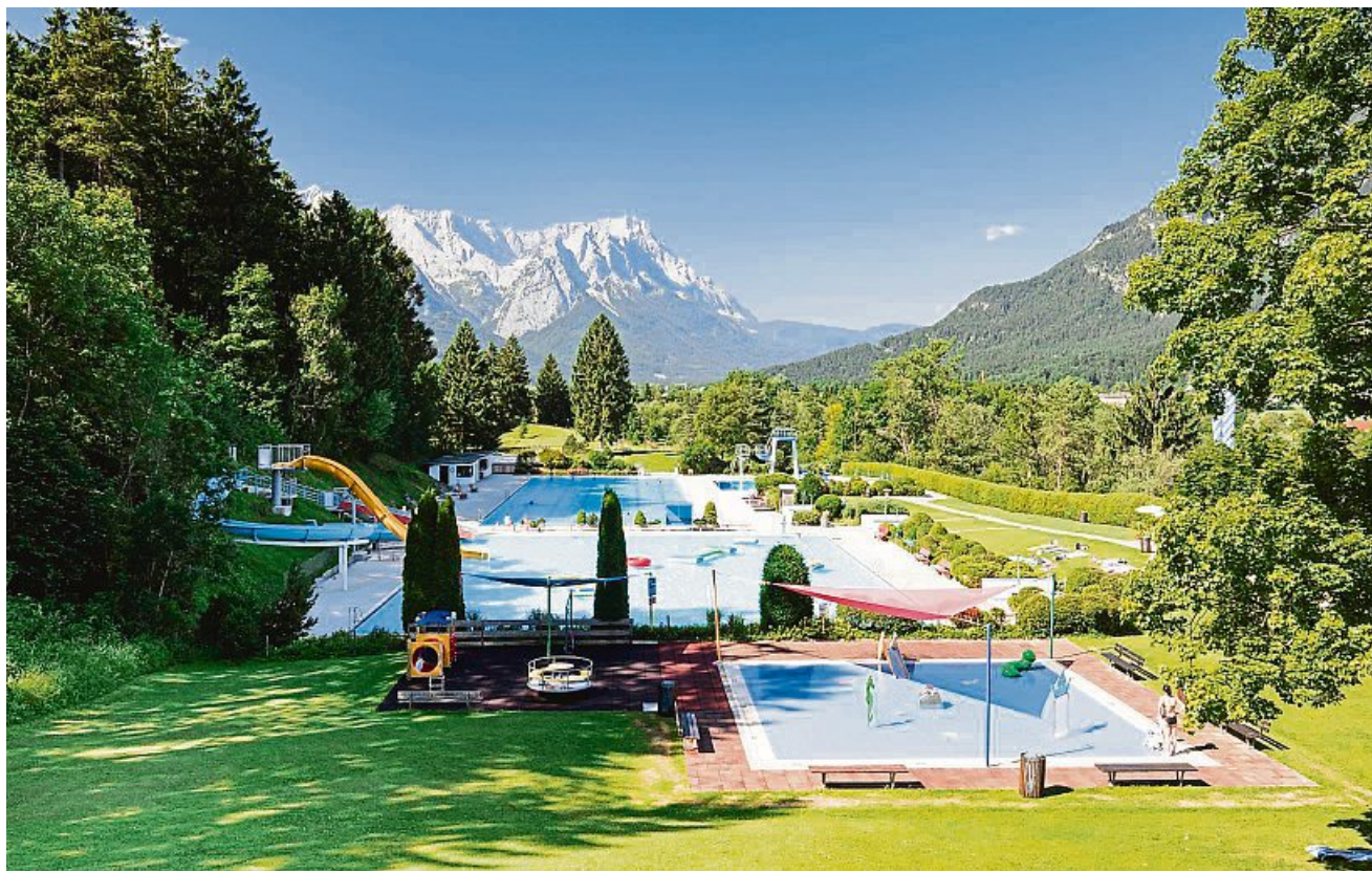
Dringend sanierungsbedürftig ist das 1973 eröffnete Wärmefreibad in Farchant. Mit diesem Thema wird sich der Nachfolger von Bürgermeister Martin Wohlketter befassen müssen.
